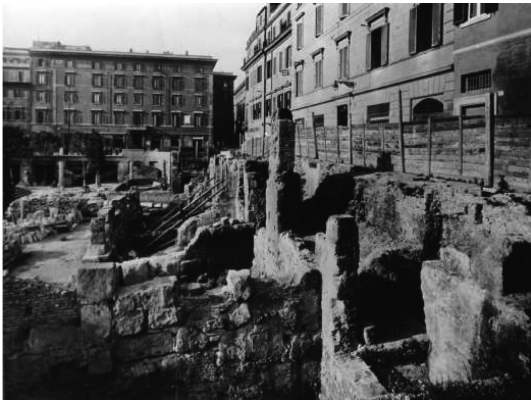
Fig. 4 - Il portico orientale durante i lavori di scavo degli anni Venti, prima della demolizione delle strutture post-classiche. ©SBACAF C1574.
