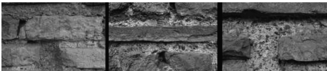
Fig. 2 - Esempio di corsi di malta. Basilica di S. Croce a Ravenna (inizi V secolo). Basilica di S. Agata Maggiore (V secolo). Basilica S. Apollinare in Classe (VI secolo) (elaborazione autore).
