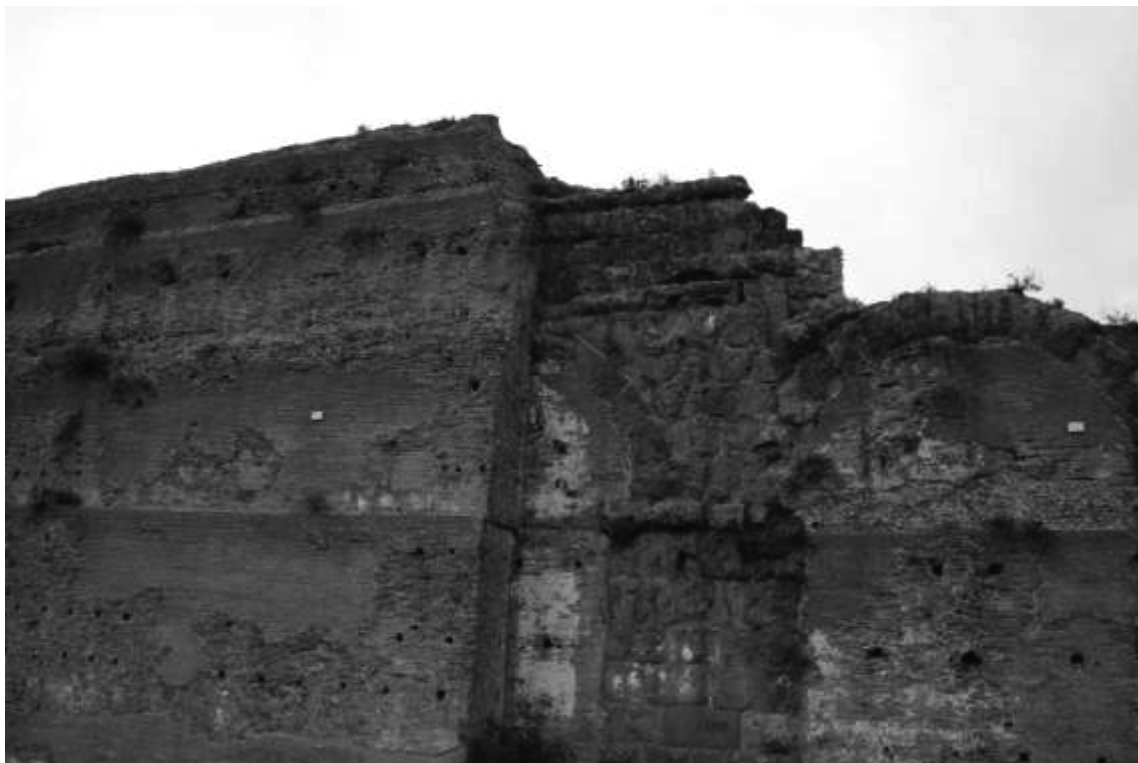
Fig. 3 – Particolare dell'intervento tardo. Si noti la presenza di cortina in facciavista anche sul lato (foto autore).
