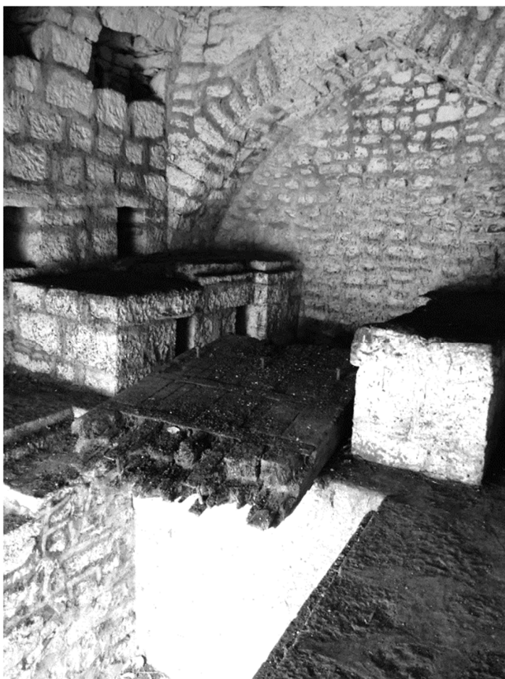
Figure 115 : chambre d'arrivée d'eau à l'intérieur du barrage
