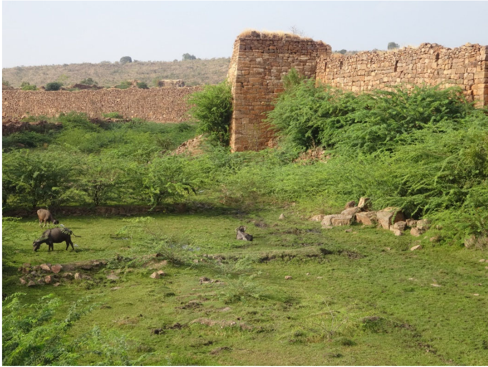
Figure 66 : vue du fossé sud
