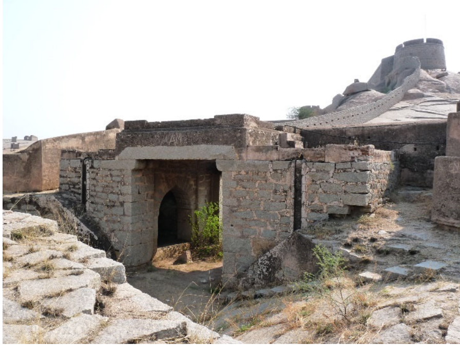
Figure 149 : tour-porte 13 au premier plan et branches tombantes à murs crénelés du 19 ème siècle en arrière-plan reliant la porte à la tour 25 de la citadelle
