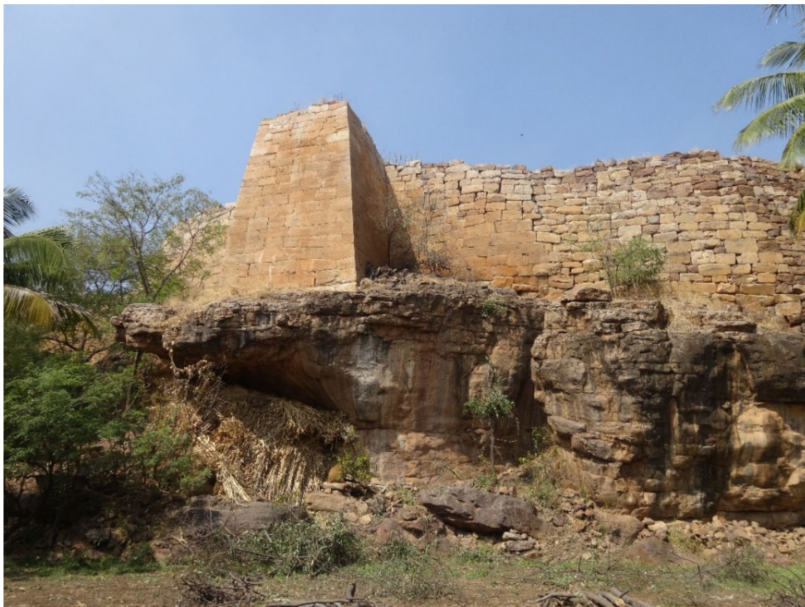
Figure 56 : la tour 61 est construite en même temps que la muraille
