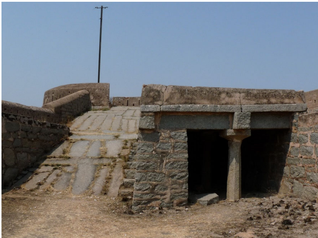
Figure 159 : rampe d'accès pavée et aménagement de réduit à la gorge du bastion 25 de la citadelle
