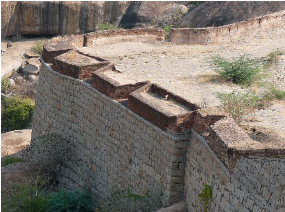
Figure 162 : parapet en caisson de brique rempli de terre de l'enceinte intermédiaire ouest (bastion 20)
