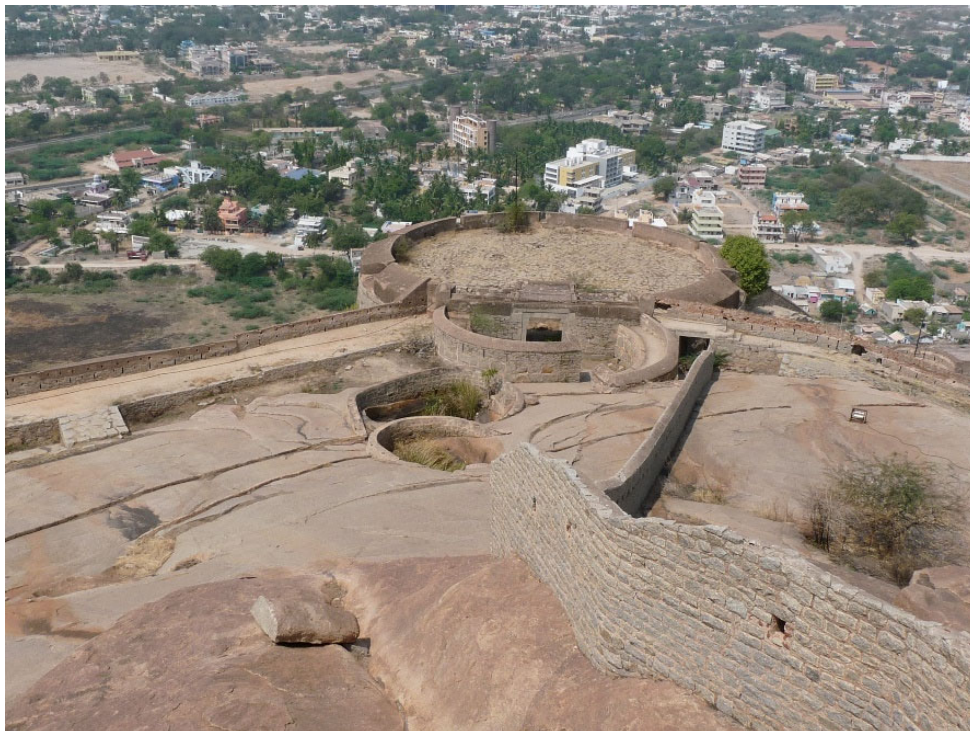
Figure 155 : porte du bastion 13 et branche tombante à murs crénelés
