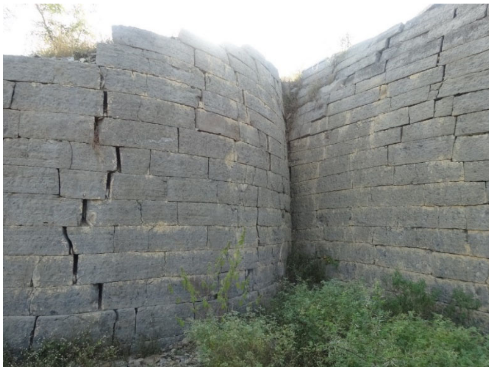
Figure 24 : tour outrepassée, muraille est
