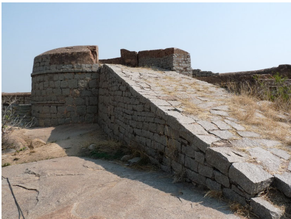
Figure 156 : rampe d'accès vers la plate-forme d'artillerie du bastion 4
