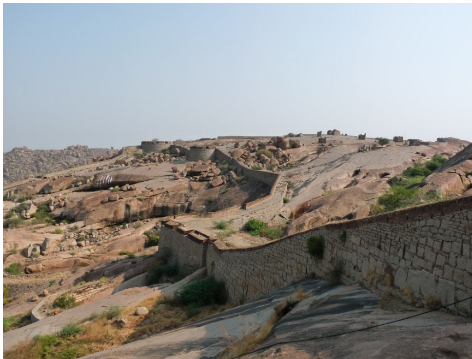
Figure 146 : front fortifié du nord-ouest marqué par l'adaptation au relief
