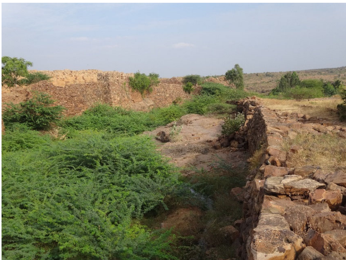
Figure 68 : vue de la contrescarpe sud
