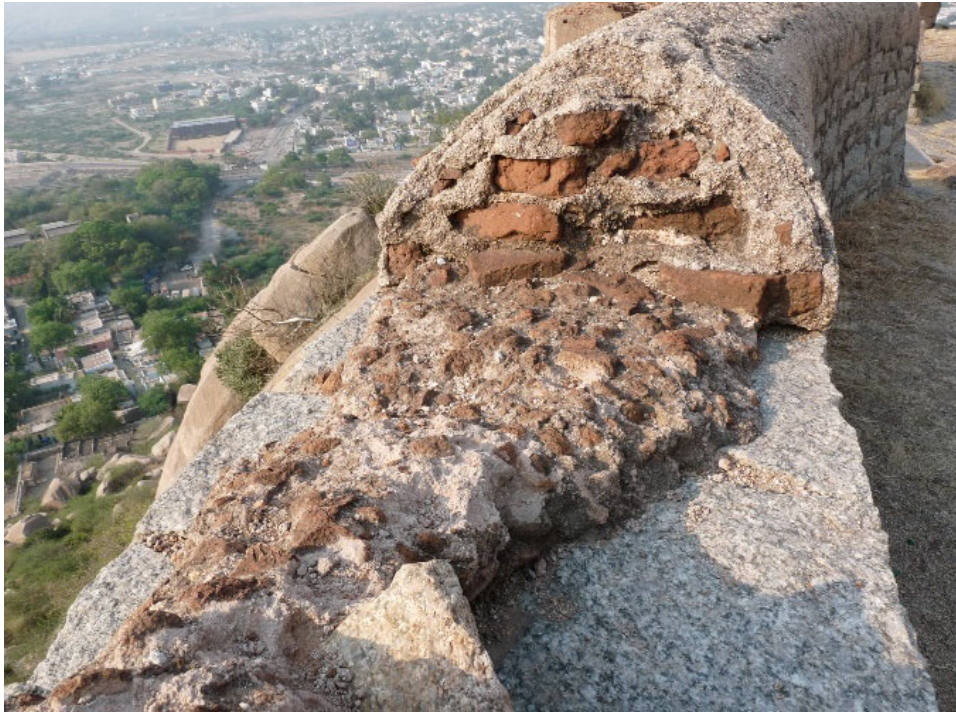
Figure 161 : vue en coupe du sommet du parapet en brique recouvert de chunam
