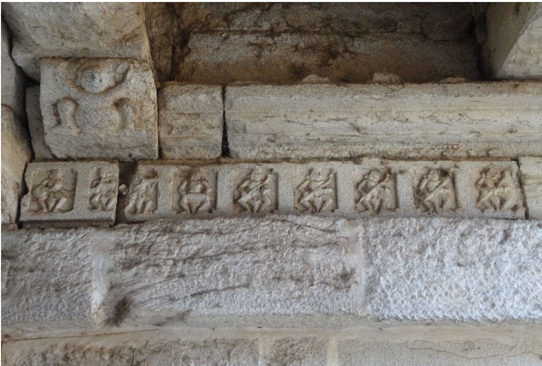
Figure 82 : réutilisation de colonnes Chalukya et frise décorative représentant des danseurs surmontée d'une console avec une figure de nain
