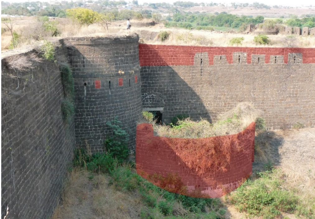
Figure 124 : surélévation de la fortification du Naya Qilah et ajout de la barbacane devant P5. L'ensemble P5 et 6 constitue une entrée tardive datant probablement des années 1560-80, lors de la construction du Naya Qilah . C'est une porte d'honneur de style mandapa traditionnelle avec un pont au-dessus d'un fossé sec, puis une porte en chicane pour accéder à une première cour entre deux lignes de fortification. Il y a de nombreuses sculptures représentant des animaux qui ornent cette entrée dont deux lions agrippant chacun un éléphant.
