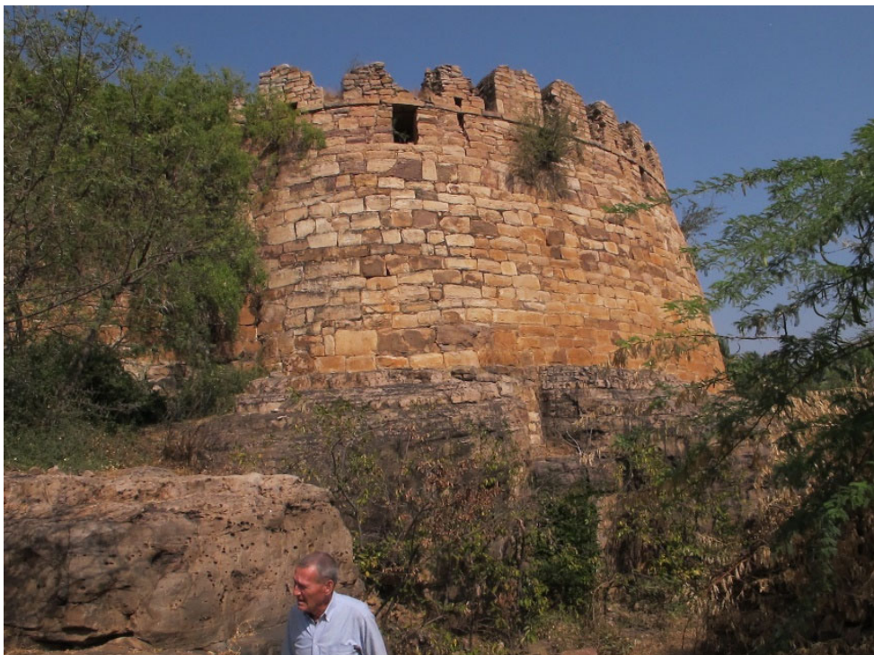
Figure 101 : la tour 62 est construite sur le rocher aménagé en partie basse pour le canal A3 amenant l'eau depuis la rivière et la tour 35 jusqu'à l'intérieur de la cité
