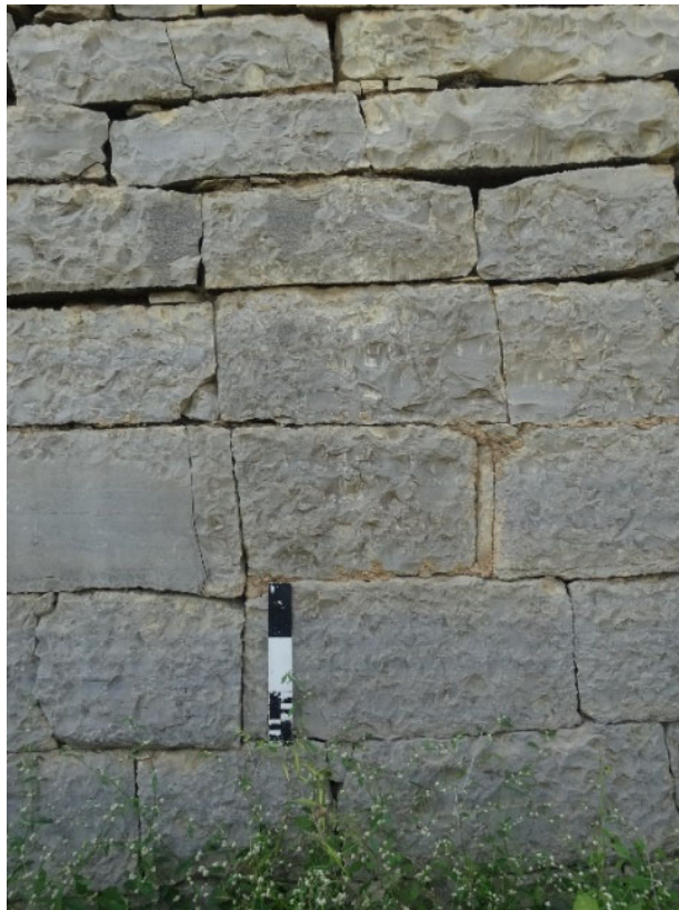
Figure 37 : détail de la mise en œuvre et des assises du parement extérieur, muraille nord
