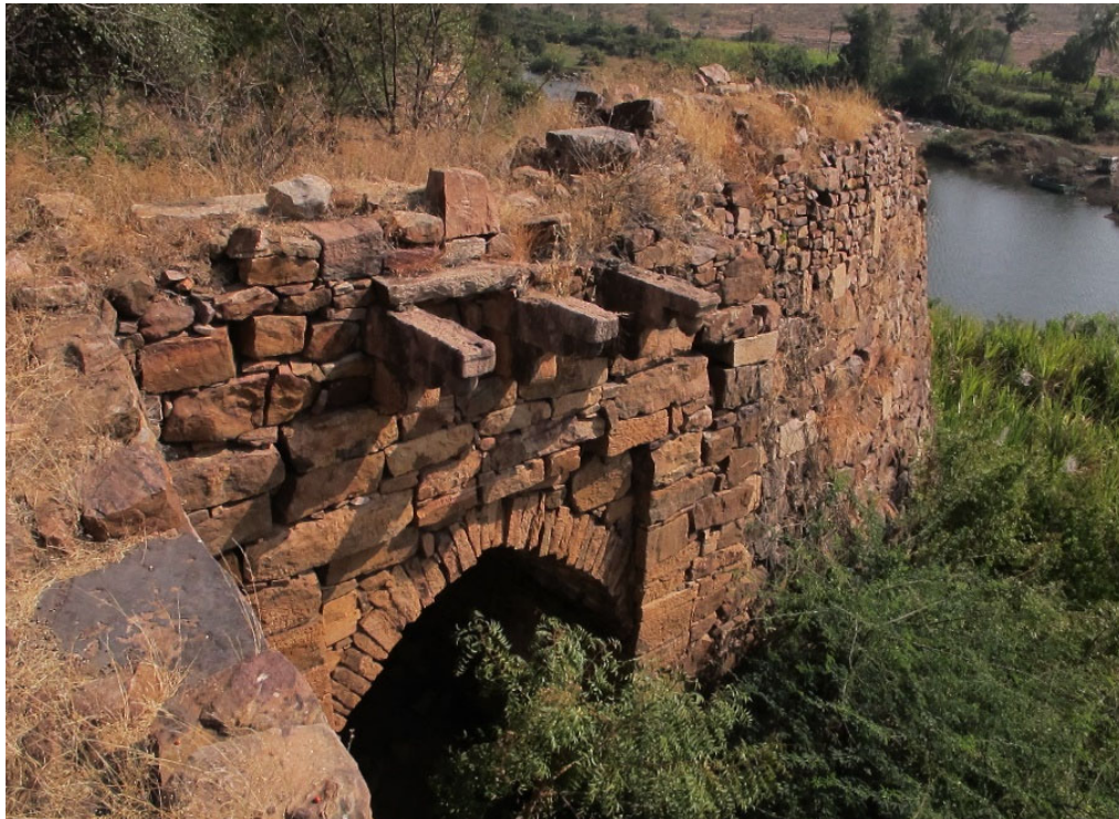
Figure 94 : porte/poterne 20 surmontée d'une bretèche
