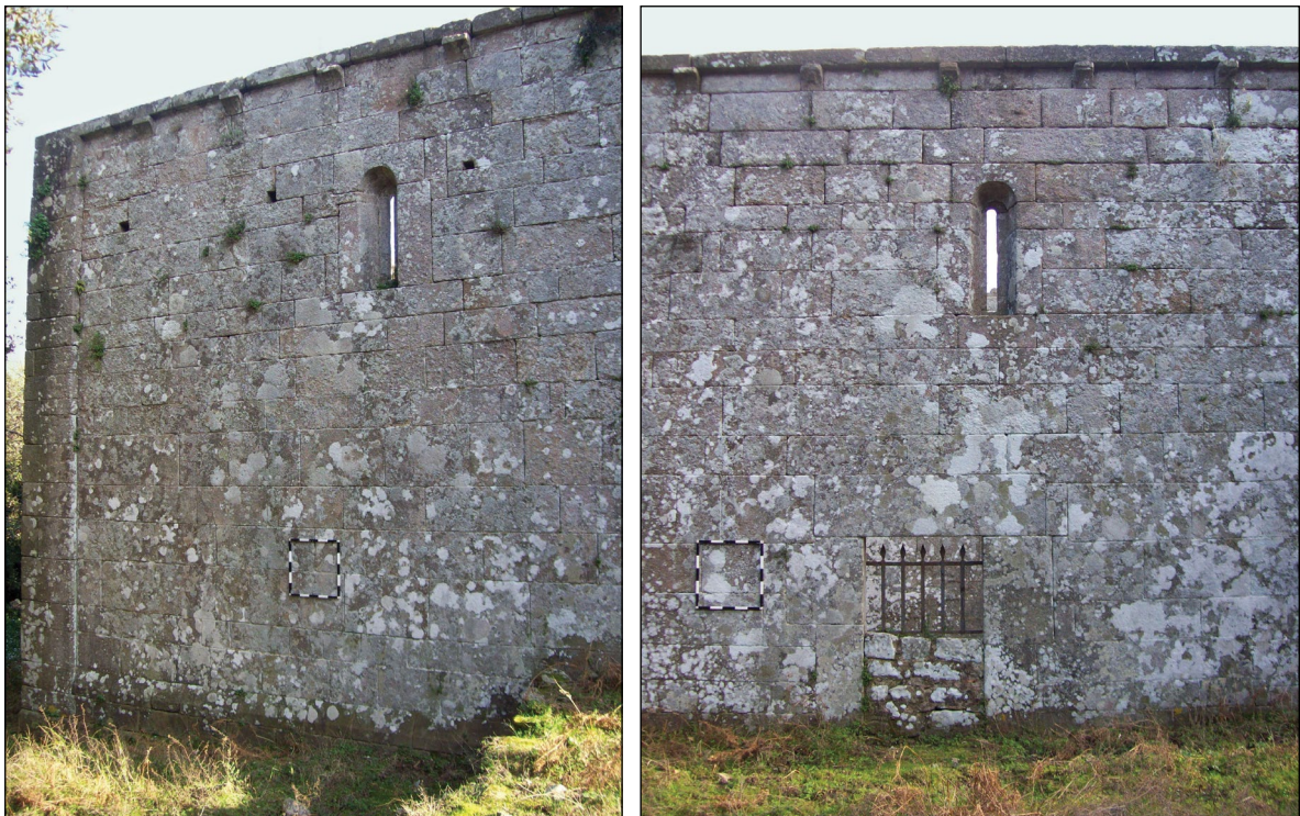
Figura 12. PP2 di San Giovanni, veduta delle fasi post medievali della monofora di sinistra e dell'apertura tamponata.
