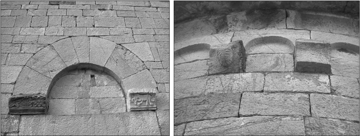
Figura 22. Particolari delle mensole del PP2 e del PP3.
