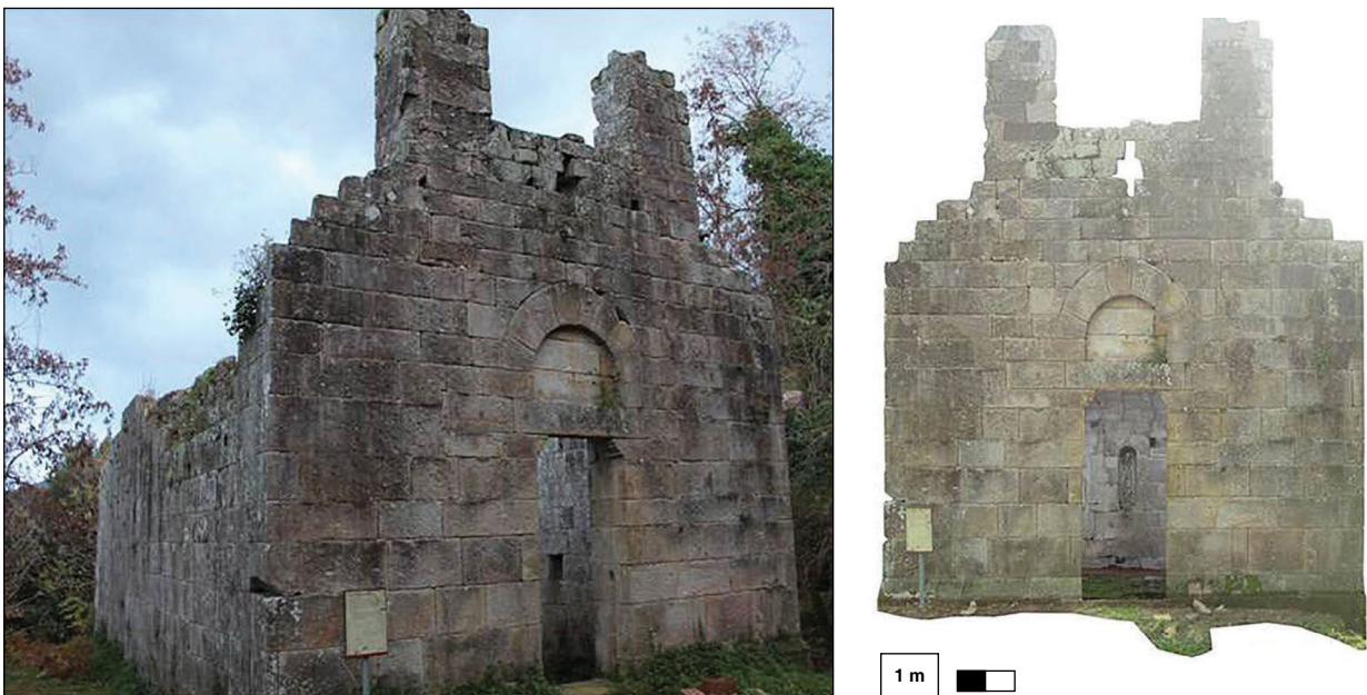
Figura 5. Veduta del PP1 di San Lorenzo e fotoraddrizzamento realizzato da I. Trifirò, I. Costantino e M. Grassini dell'Università di Ingegneria di Pisa.
