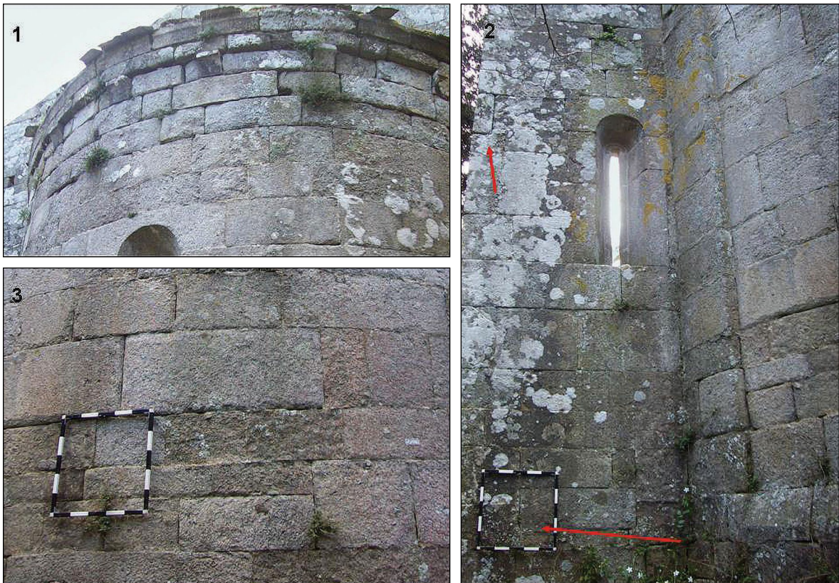
Figura 13. Veduta della monofora centrale del PG 1 e della ricostruzione post medievale della parte superiore del prospetto (USM 251) (1), di una delle paraste angolari (2) e dello sdoppiamento dei filari in USM 122 (3).
